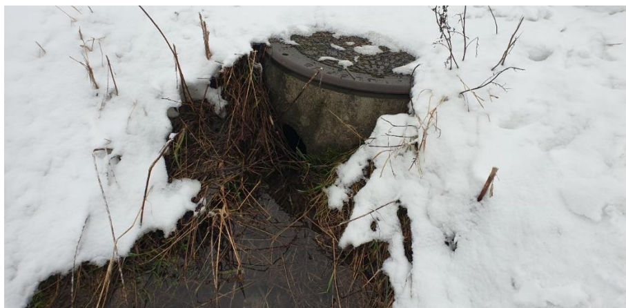
FIGUR 9 INNLØPSKUM PÅ OVERSIDEN AV SAKSUMSDALSVEGEN
