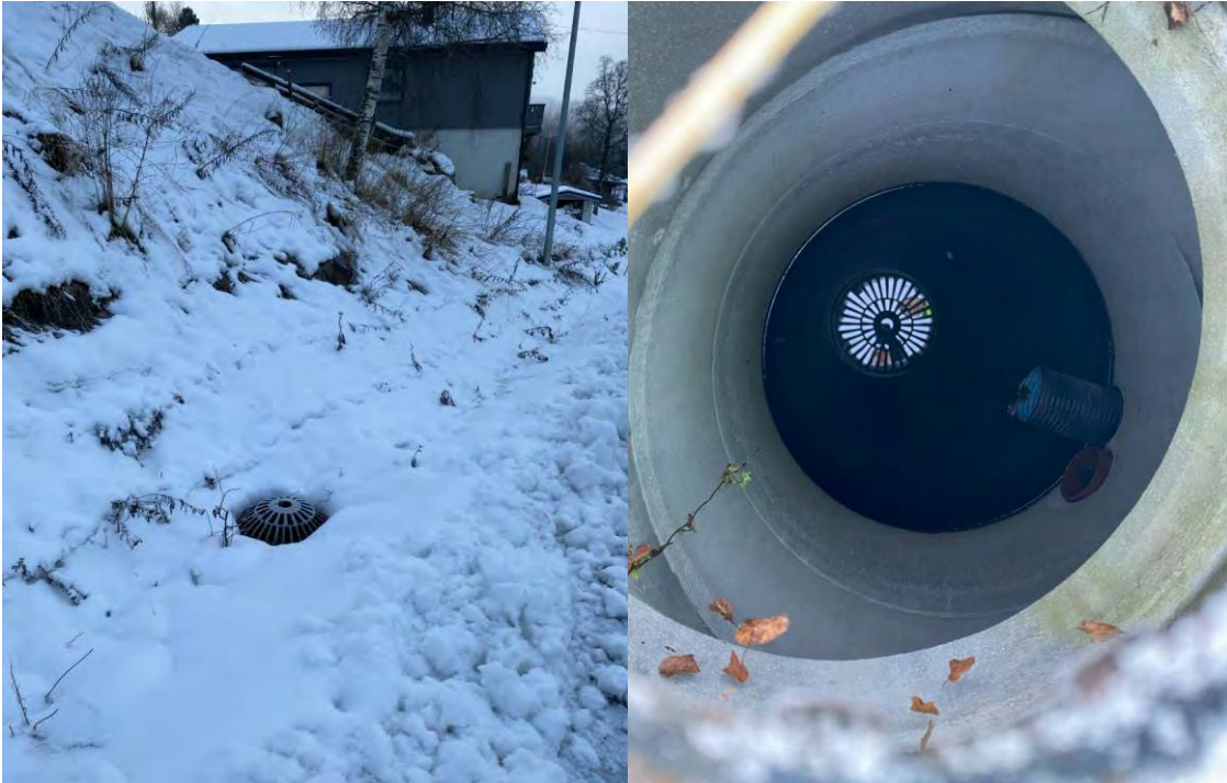
Figur 13. Innløpsrist til sandfang i grøft på innsiden av gangveg sørvest for reguleringsområdet. Punkt 8 i Figur 3. Rør fra sandfang går ut mot vegen.
