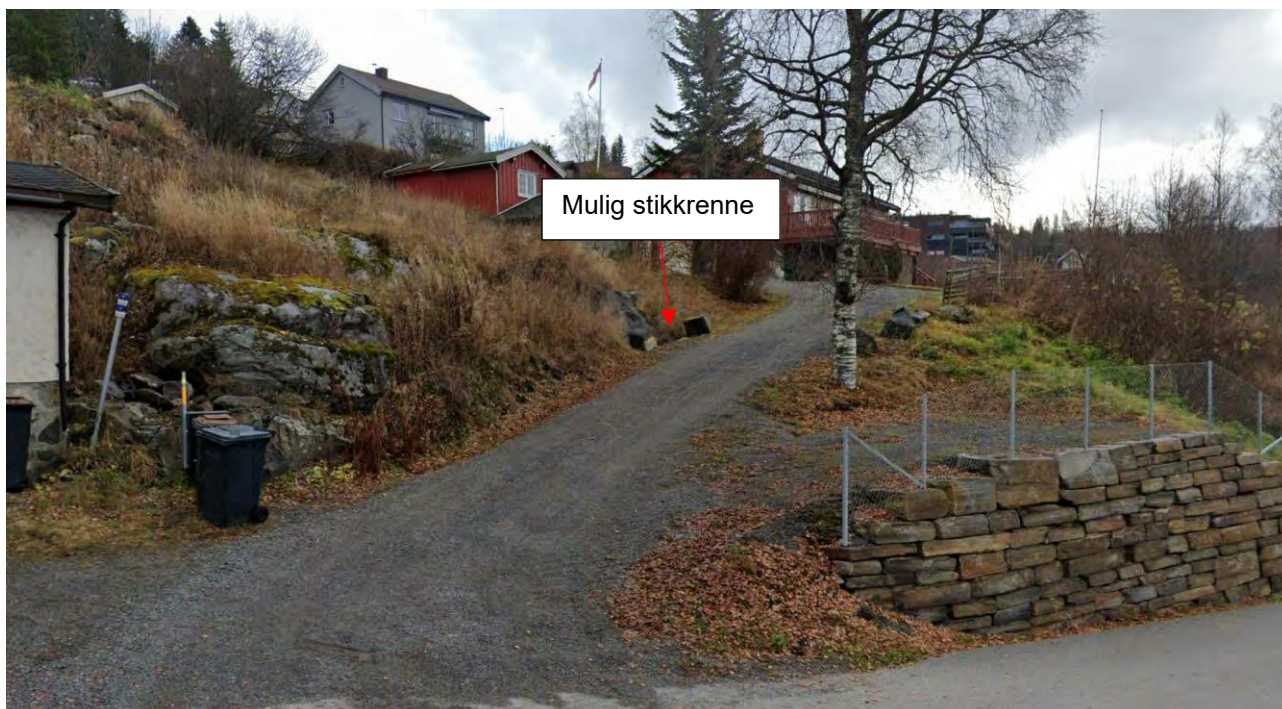
Figur 19. Bilde fra google street view tatt november 2022. Mulig stikkrenne er markert. Mangel på grøfter, og lite erosjonsskader på grusvegen tyder på at vannet mest sannsynlig renner til et stikkrenneinnløp.
