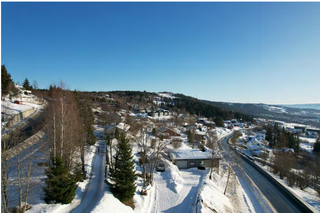
Figur 7: Oversiktsbilde planområdet. Kilde: bilde fra befaring.
