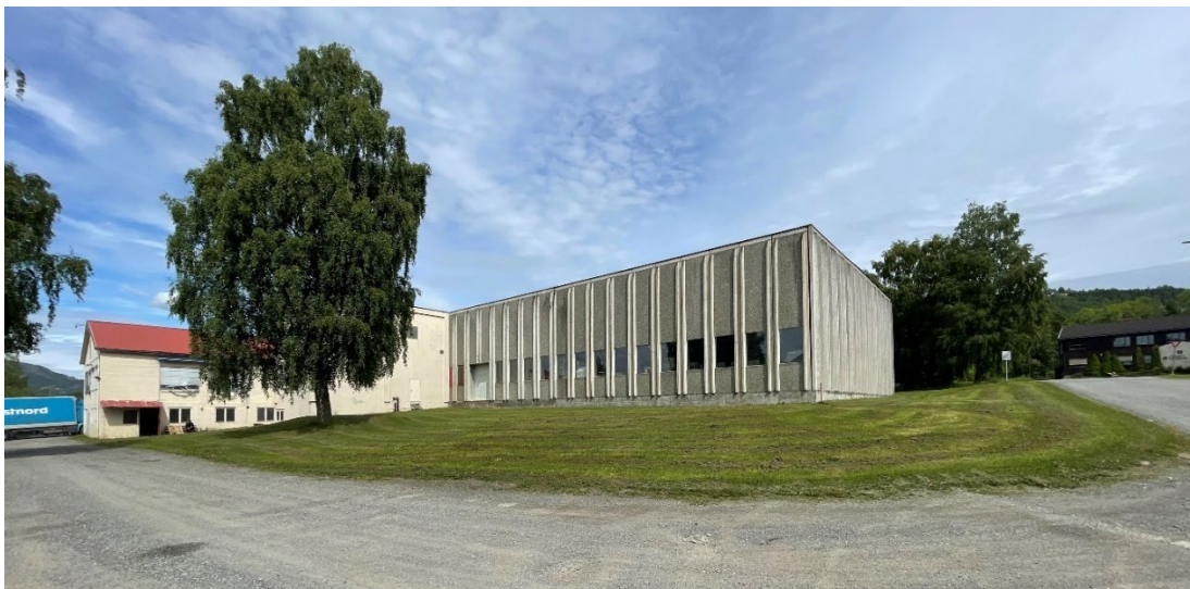
Figur 6: Bilde fra befaring, planområdet sett fra Hagevegen
