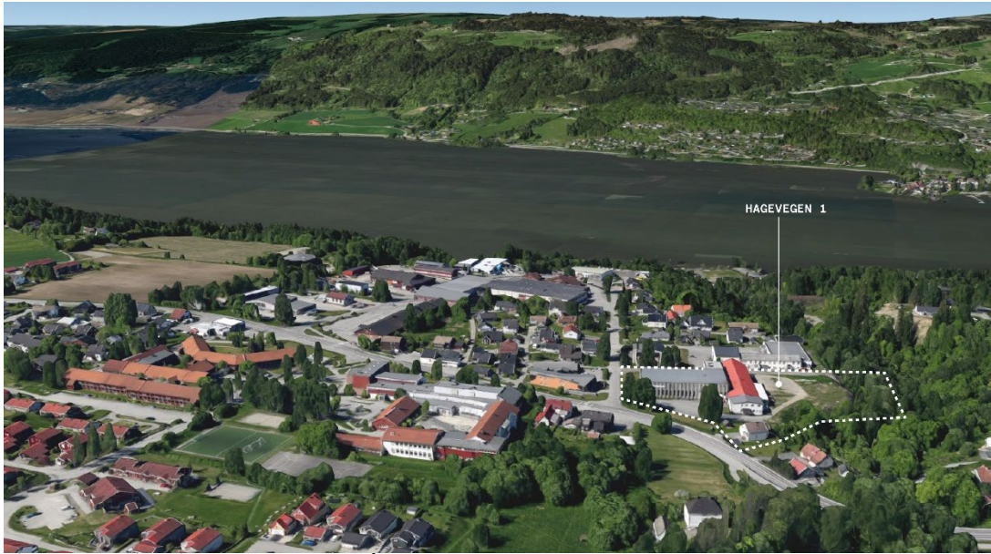
Figur 5: Oversiktsbilde Hagevegen området, sett mot vest
