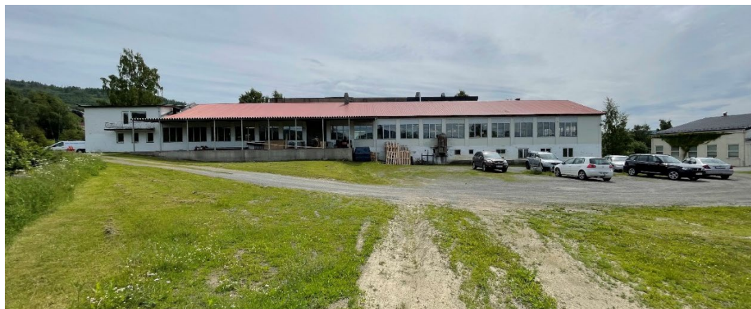
Figur 7: Bilde fra befaring, planområdet sett fra nord
