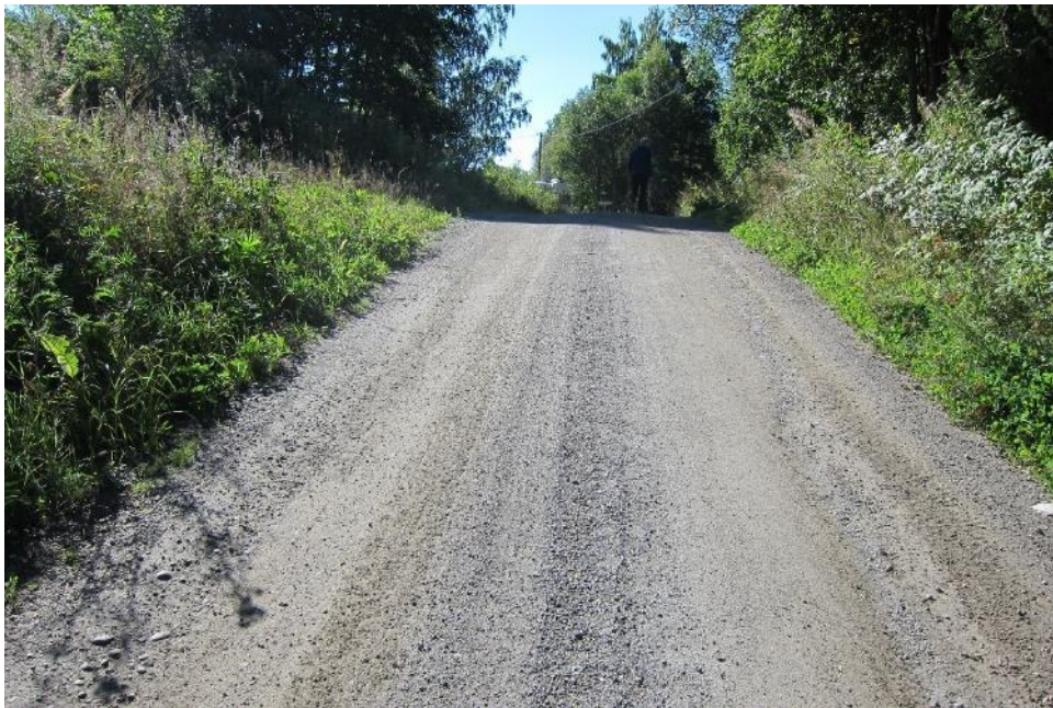
Bilde 1: Viser at dagens vegstandard for KV2 er godt rustet for anleggstrafikk i forbindelse med planlagt aktivitet i grustaket.
