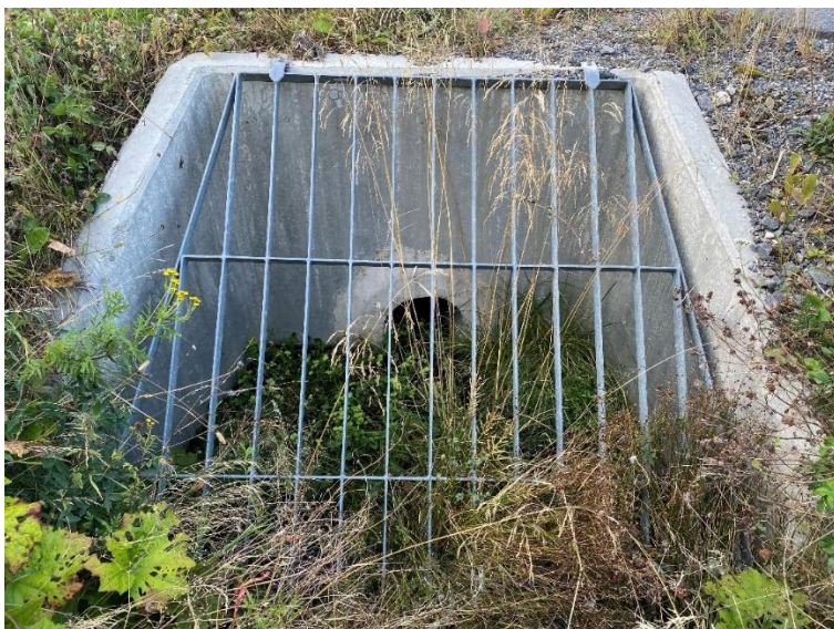
Figur 18 Utforming av bekkelukking nedstrøms planområdet.
