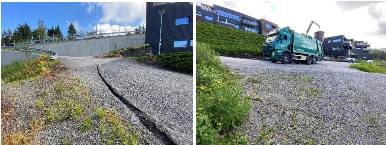
Figur 10 Bildet til venstre viser tydelig erosjon og flomvei mot B1 og B3. Bildet til høyre viser at innkjøringen til huset i B3 heller slik at vannet kommer rett inn mot området. Det er laget en nedsenkning i asfalten som fører noe vann mot en slukrist helt til høyre i bildet.
