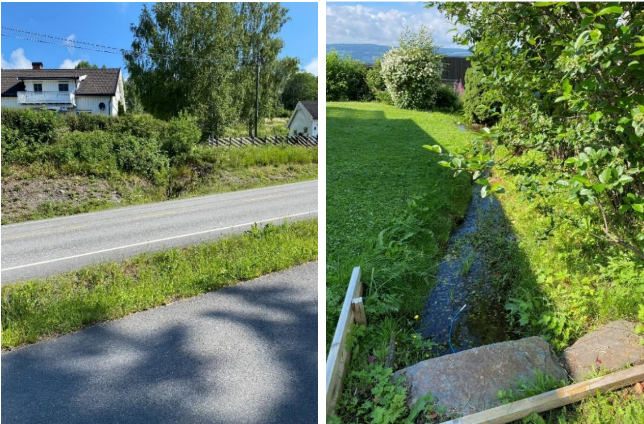
Figur 9 Bildet til venstre viser innløpet til bekkelukkingen under Nordsetervegen. Bildet er tatt fra nedstrøms området mot innløp bekkelukking. Bilde til høyre viser et åpent strekke (sett fra nedstrøms) før det igjen går i en lengre bekkelukking som fører vannet direkte til Skurva.
