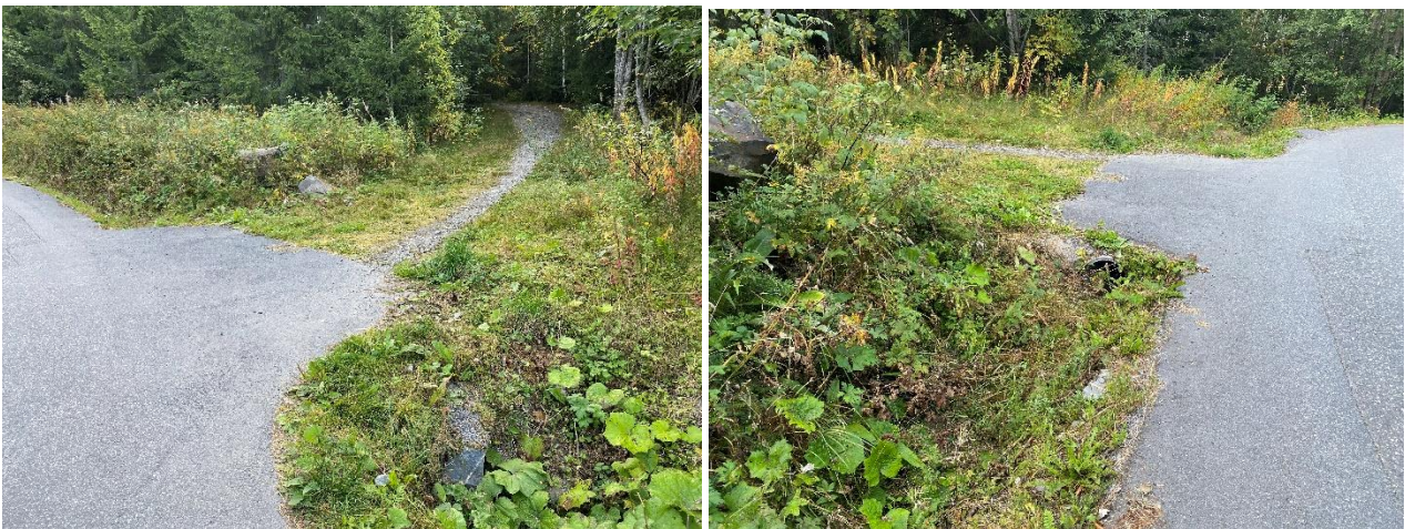
Figur 17 Bildene viser stikkrenne under sti som bør endres for å sikre at flomveien til Skurva ledes tilbake til Skurva. Bilde til venstre er tatt fra nedstrøms og oppover, og bilde til høyre fra oppstrøms og nedover.
