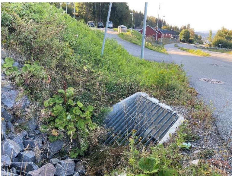
Figur 19 Viser bekkeinntak nedstrøms planområdet ved Nordsetervegen. Til høyre i bildet ser det ut som at flomveien til lukkingen gå ut i Skurva.
