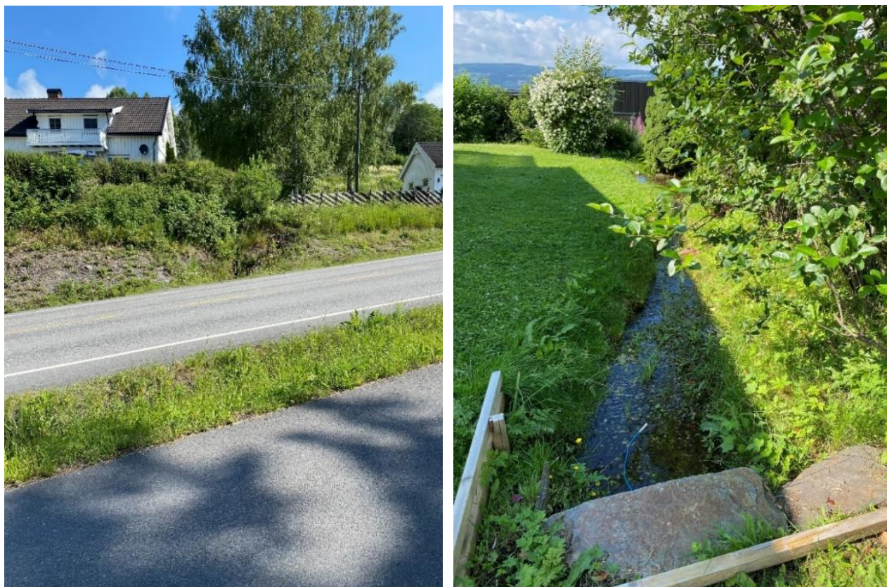
Figur 9 Bildet til venstre viser innløpet til bekkelukkingen under Nordsetervegen. Bildet er tatt fra nedstrøms området mot innløp bekkelukking. Bilde til høyre viser et åpent strekke (sett fra nedstrøms) før det igjen går i en lengre bekkelukking som fører vannet direkte til Skurva.
