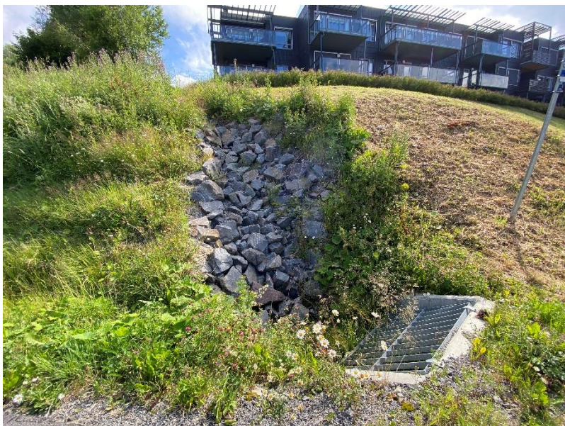
Figur 12 Viser bekkeinntak ved Nordsetervegen nedstrøms planområdet.
