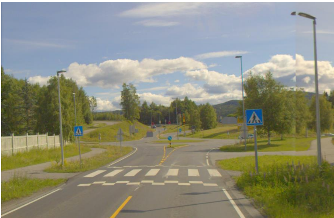
Figur 5 Forsterket belysning ved dagens gangfelt S4D1 m 13890. (vegbilder.atlas.vegvesen.no)
