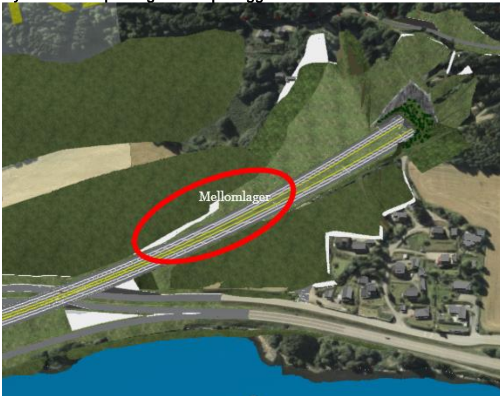
Figur 3 Illustrasjon av mellomlagringsområdet ved Øyresvika og Vingnes. Tunnel påhugg Sør.
