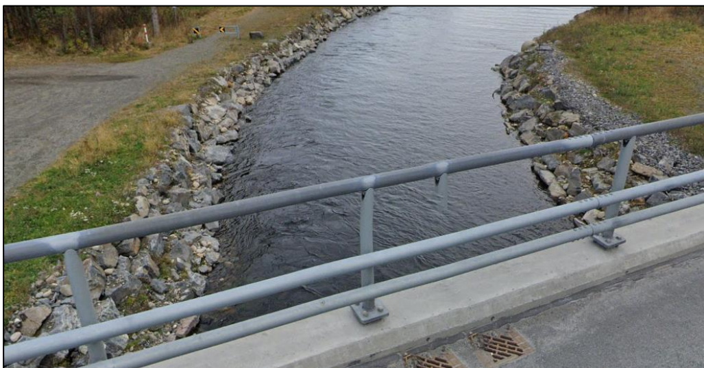
Figur 28: Eksisterende erosjonssikring nedstrøms dagens bru E6 over Rinda (Bilde fra Google maps)
