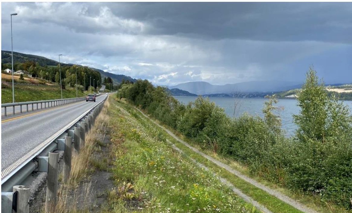
Figur 5-12. Den typiske grønnstrukturen mellom dagens europavei og strandkanten mot Mjøsa består av noen få meter med trær og busker. Disse smale sonene har trolig begrenset verdi for vegetasjon og naturtyper.
