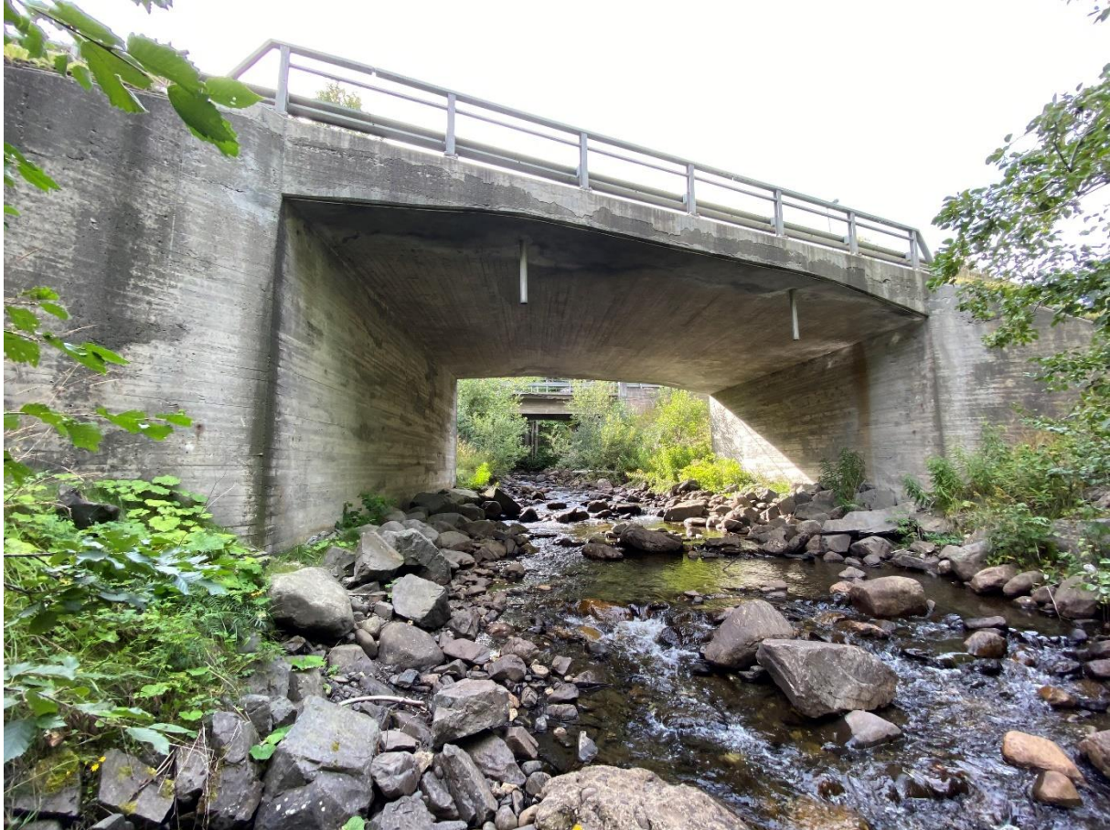
Figur 5-10. Under brua over Bjørnstadelva vil det være fremkommelig for de fleste dyrearter. Dessverre leder denne rett inn i campingplassen og har følgelig liten verdi for dyr som skyr menneskelig aktivitet.
