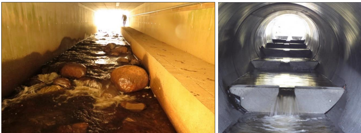
Figur 7-4. Eksempel på støpt kulvert med naturlig elvebunn som ikke innebærer fysisk vandringshindring inkludert bankett på den ene siden som gjør kulverten passerbar for mindre landlevende dyr under normale vannføringer (foto: Lars Bendixby og A. Rikstad).
