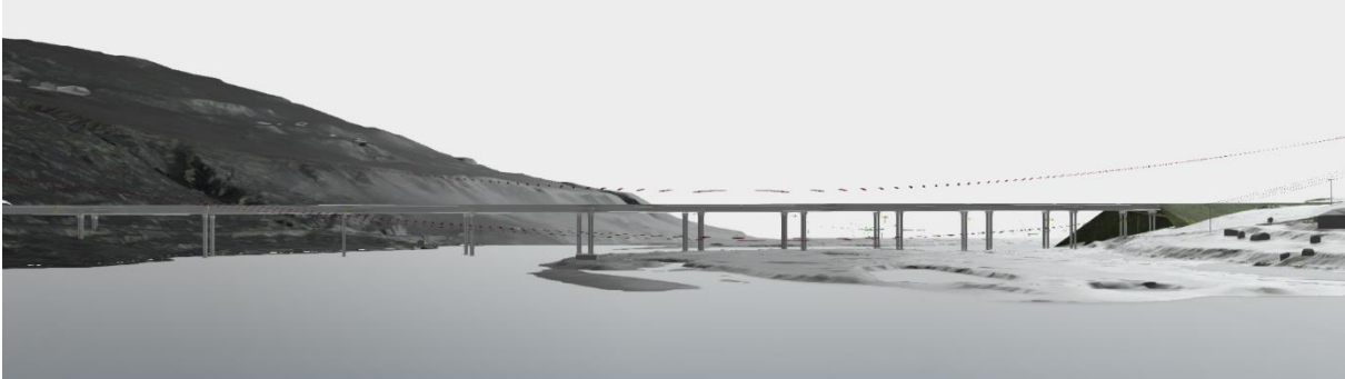
Figur 5-44. Planprogramløsningen gjør at brua flyttes ca. 100 meter nordover. Den nordlige og øverste ledningen krysser over brua. Den nedre ledningen vil henge et stykke sør for elva og høydemessig ligge midt i frihøyden under brua. Som for øvrige løsninger er samvirkningen mellom bru og ledninger meget uheldig.
