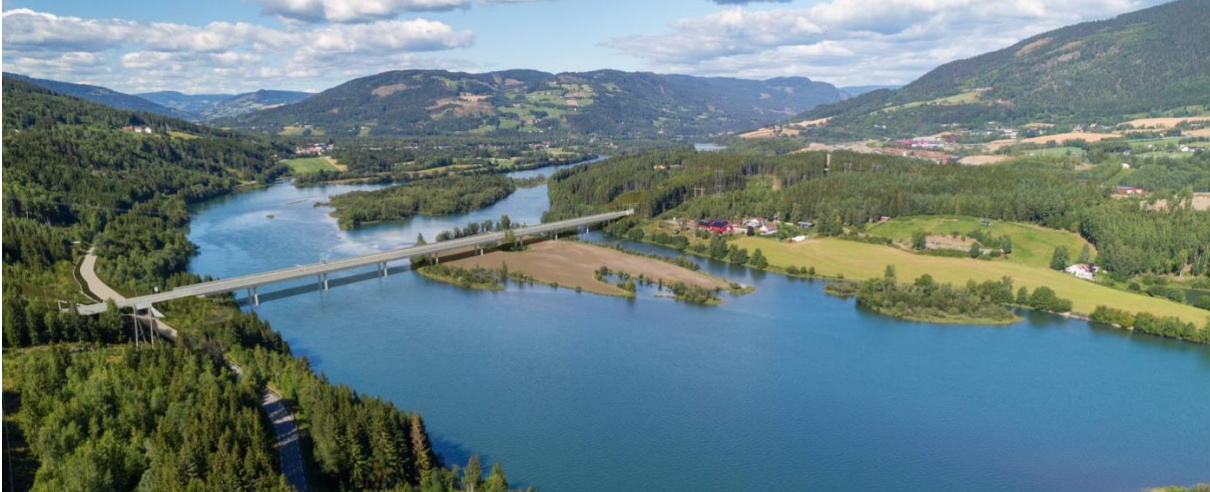
Figur 1-13. Lågen bru i justert linje, betongkassebru
