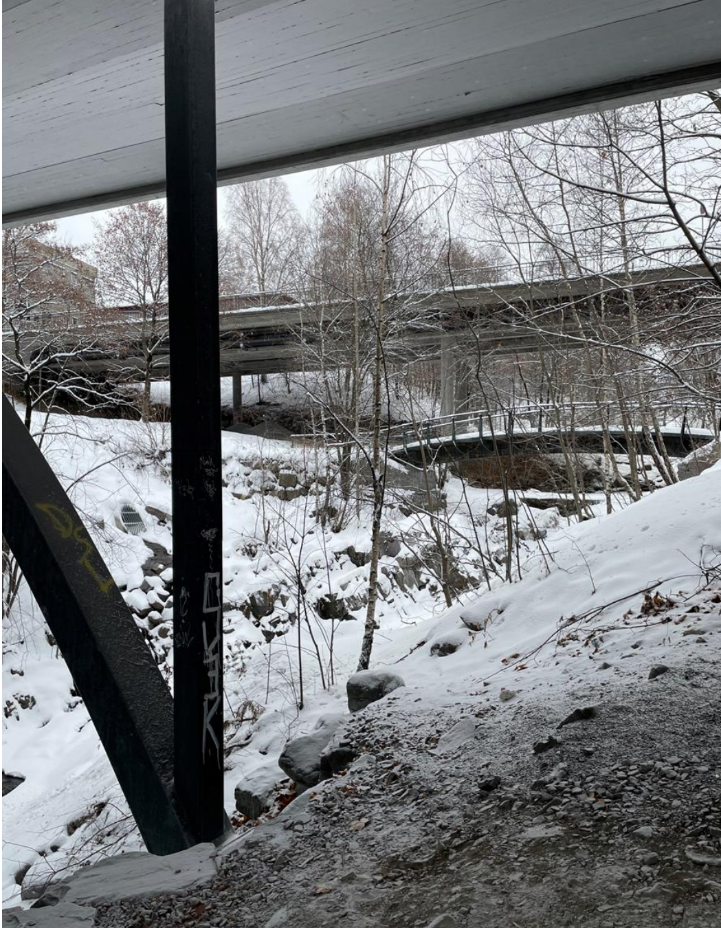
Figur 7-8 Vegbru og gangbru.
