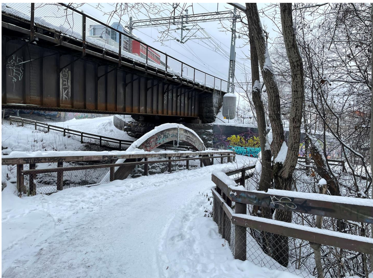
Figur 7-9 Vegbru og jernbaneovergang.
