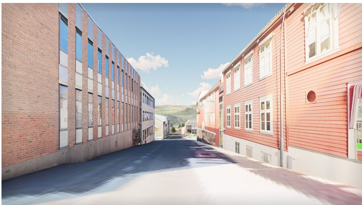
Figur 29 Dagens situasjon sett fra krysset Jernbanegata- Storgata.
