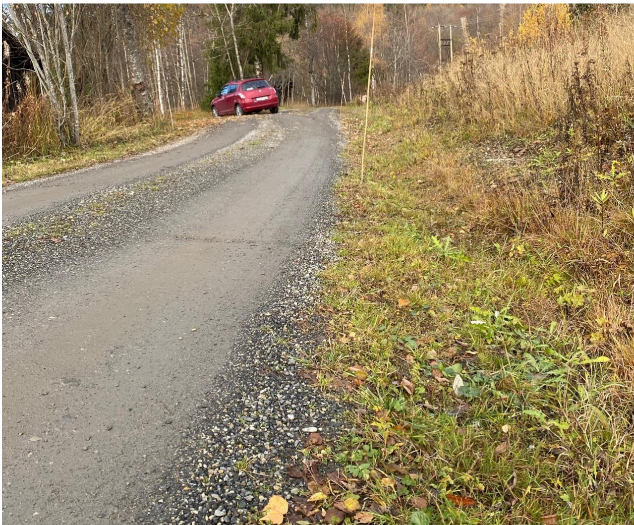
Figur 8. Grøft langs vegen vest for planområdet. Vannet i grøfta vil her renne mot sør.
