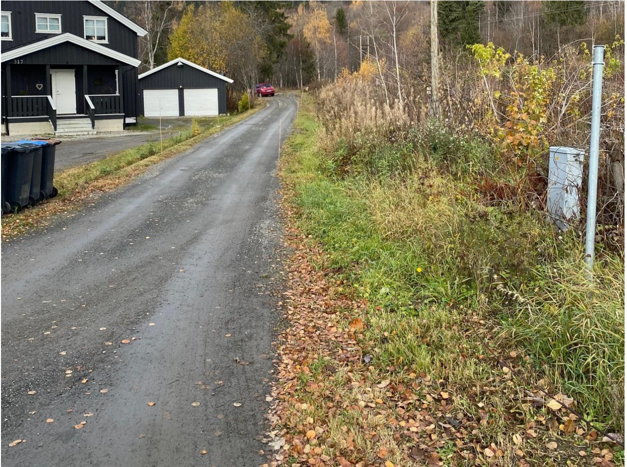
Figur 7. Grøft lags vegen vest for planområdet. Vannet i grøfta vil renne mot lavpunkt ca. midt i bildet, hvor stikkrenna i Figur 3 ligger.
