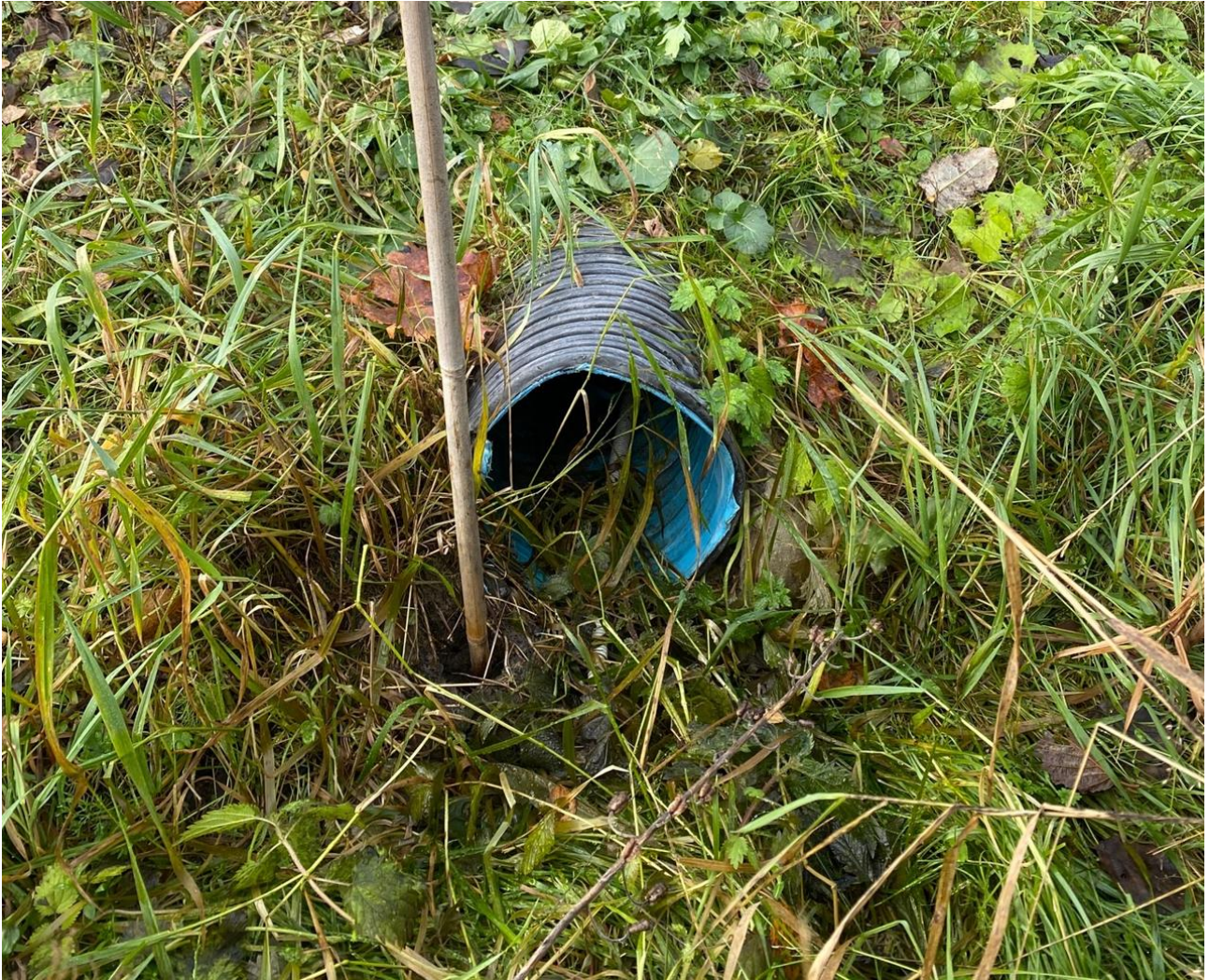
Figur 6. Stikkrenne i grøft med dimensjon 250 mm vist i Figur 3.
