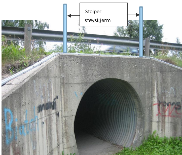
Figur 5-12: Bru nr. 05-1187 Strand bru
