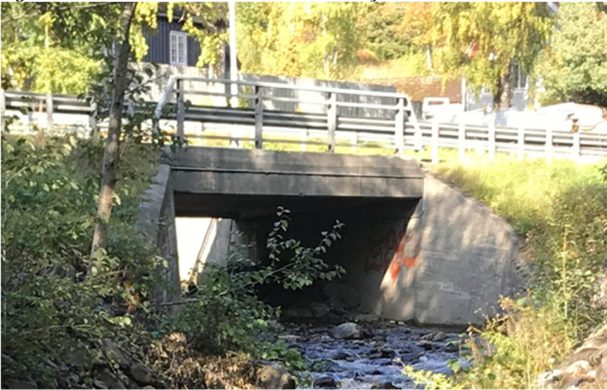
Figur 5-2: Bru under E6. Bru nr. 05-0646 Øyre bru
