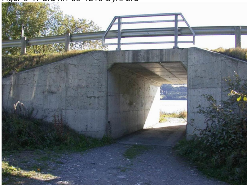
Figur 5-9: Bru nr. 05-1210 Øyre bru
